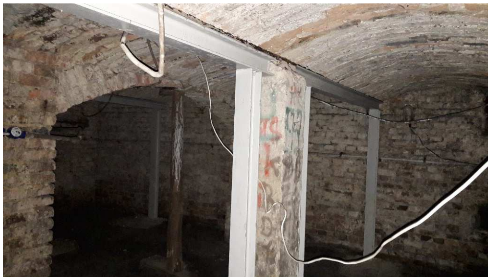
Rys. 13. Wzmocnienie przez podparcie liniowe każdej z belek stropu odcinkowego
