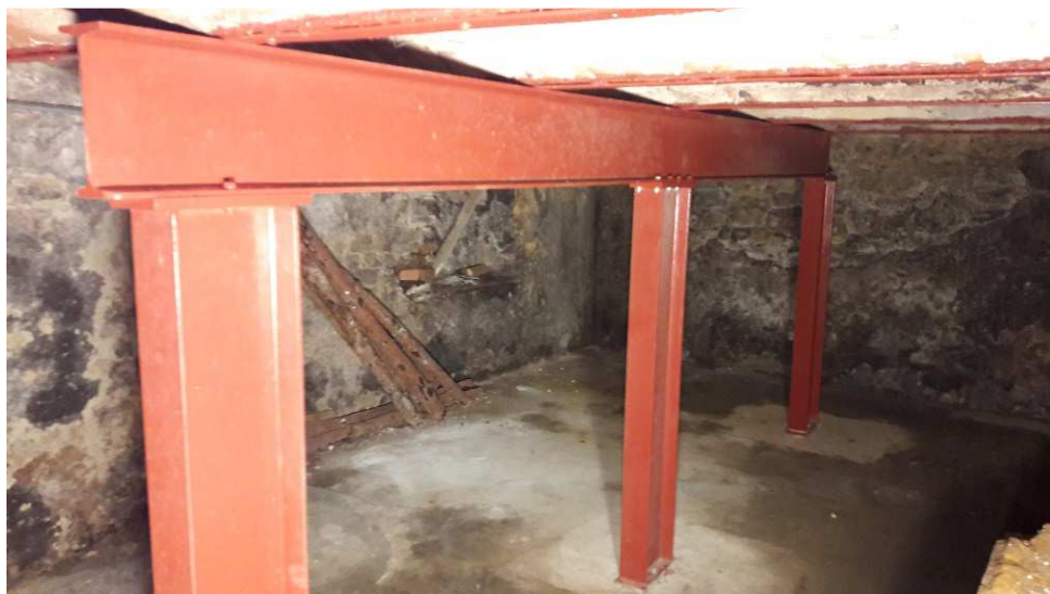
Rys. 12. Wzmocnienie w środku rozpiętości belek stropu odcinkowego
