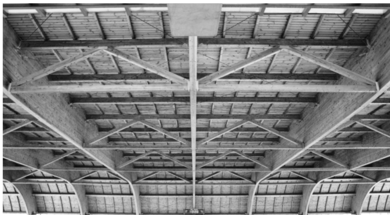
Rys. 2. Widok stężeń konstrukcji dachu
