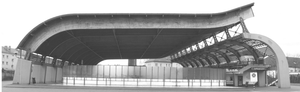
Rys. 1. Widok konstrukcji zadaszenia lodowiska miejskiego
