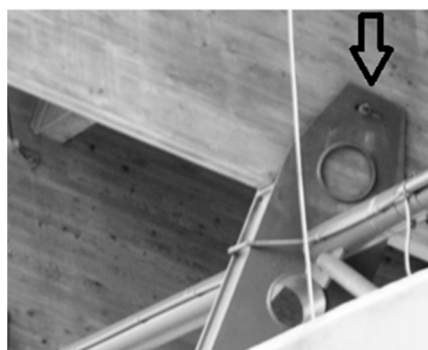
Rys. 7. Przesunięcie dźwigarów środkowych na podporze górnej (widok od strony pobocznicy B)
