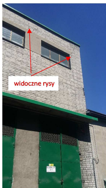
Rys. 9, 10. Wschodni narożnik budynku – widoczne spękania biegnące przez całą wysokość kondygnacji I piętra
