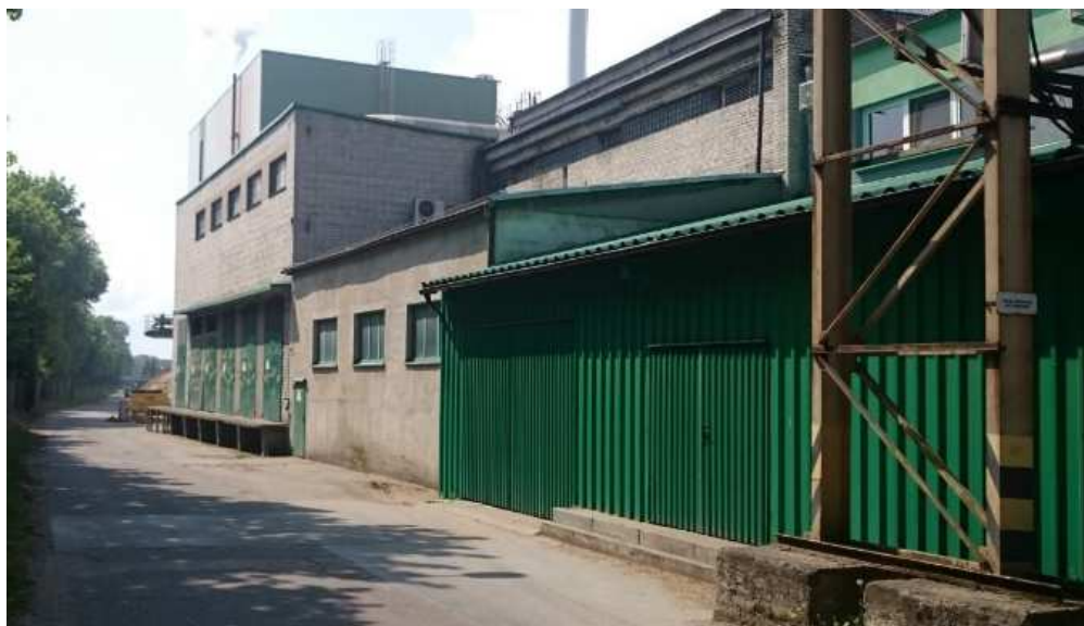
Rys. 1. Widok budynku od strony wschodniej
