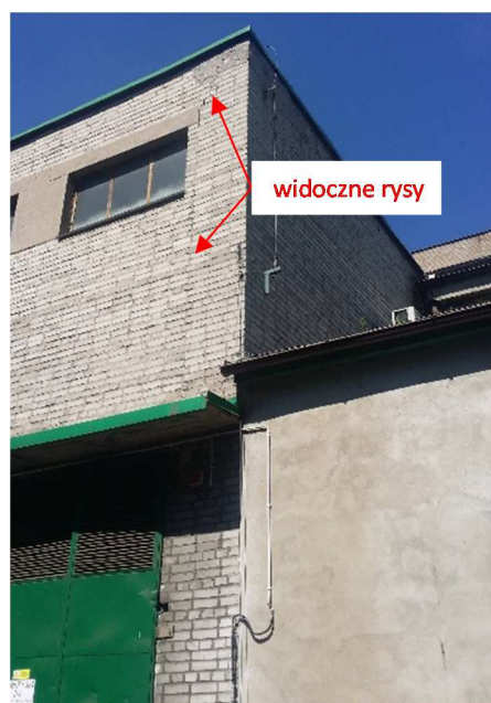
Rys. 9, 10. Wschodni narożnik budynku – widoczne spękania biegnące przez całą wysokość kondygnacji I piętra
