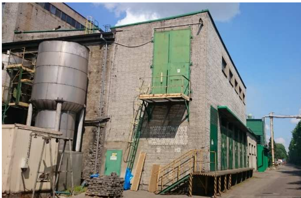
Rys. 2. Widok budynku od strony zachodniej
