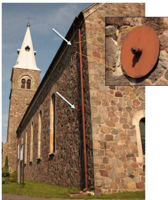
Rys. 4. Lokalizacja ściągów ściany frontowej
