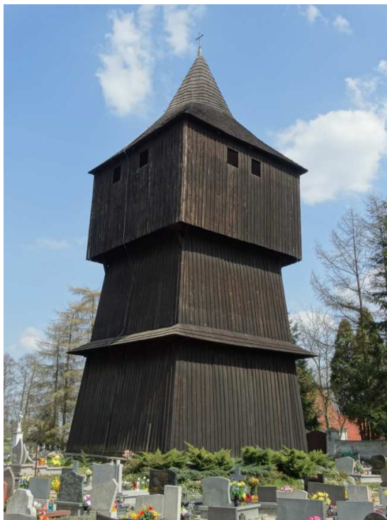
Rys. 2. Widok wieży od strony południowo-zachodniej
