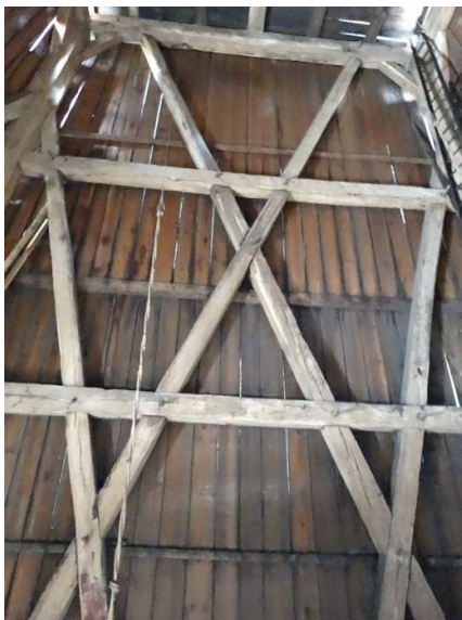
Rys. 4. Fragment konstrukcji nośnej dolnej części wieży i izbicy
