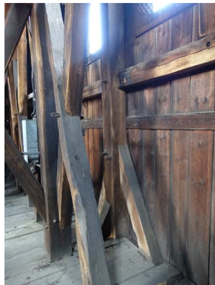
Rys. 4. Fragment konstrukcji nośnej dolnej części wieży i izbicy
