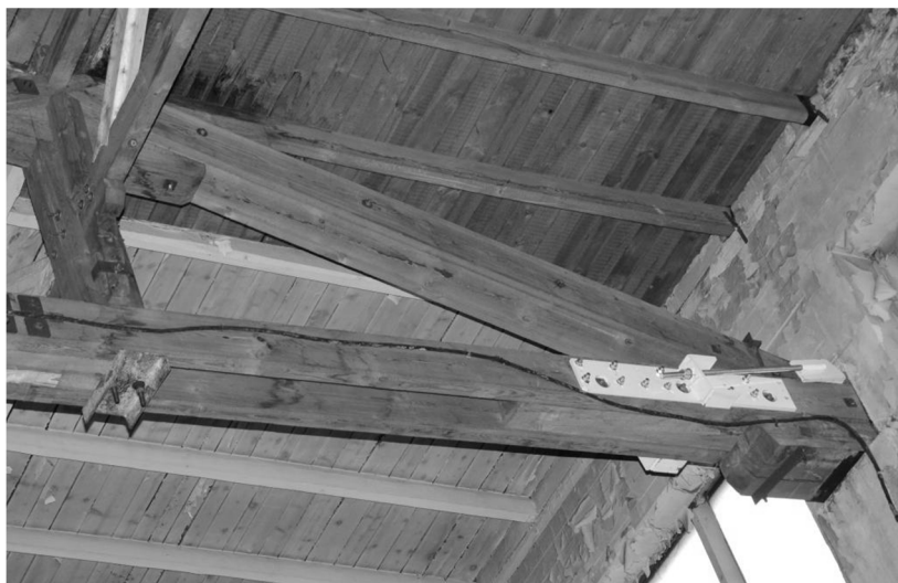
Rys. 16. Widok węzła po naprawie
