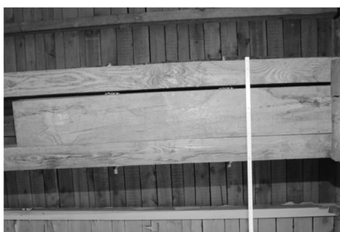
Rys. 13. Widok połączenia z pierścieniami zębatymi \phi 62\text{ mm}
