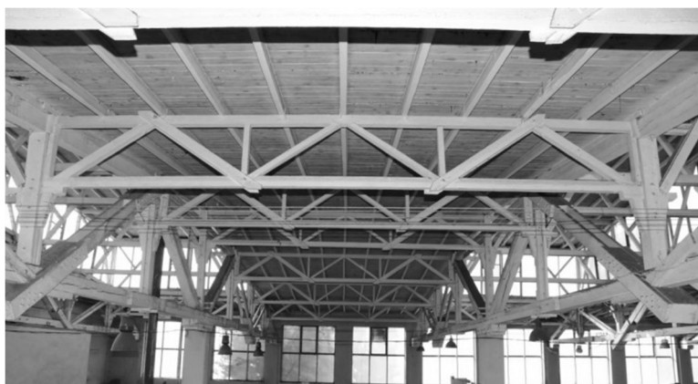
Rys. 4. Widok płatwi kratowych pomiędzy świetlniami
