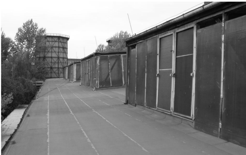
Rys. 5. Widok fragmentu dachu i świetlni dachowych
