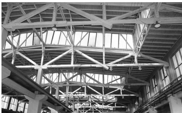
Rys. 2. Widok od środka fragmentu przekrycia hali nawy północnej
