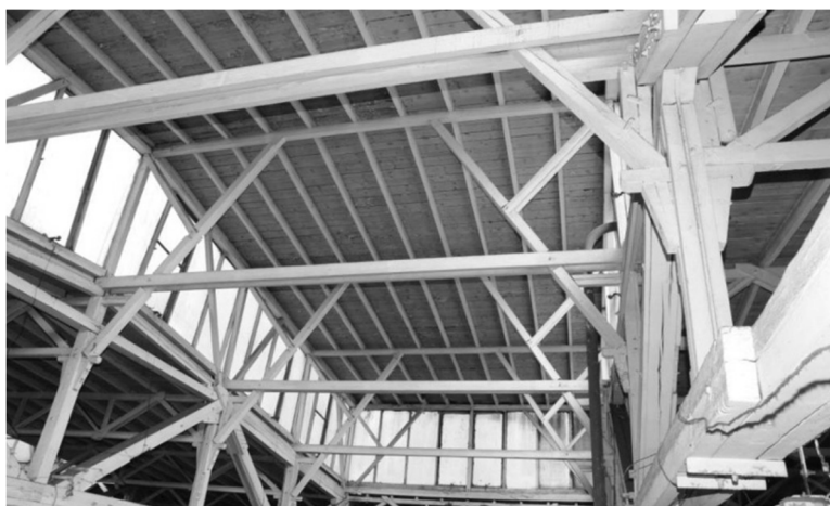
Rys. 3. Widok, od spodu, konstrukcji świetlni
