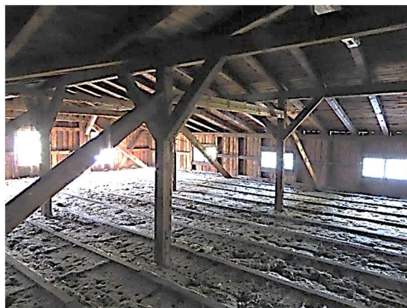
Rys. 11. Konstrukcja wieszarowa dachu
