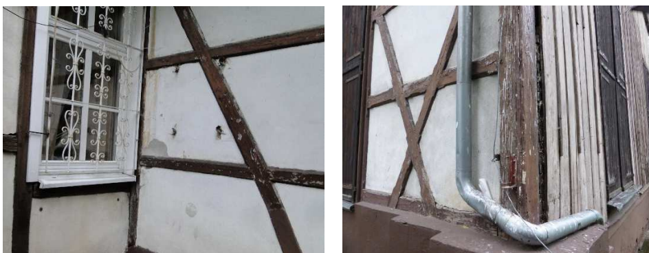
Rys. 10. Elementy drewniane konstrukcji budynku
