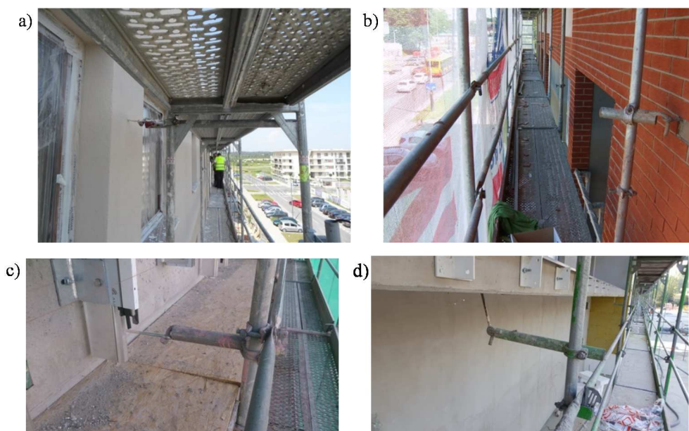
Rys. 9. Przykłady realizacji kotwienia rusztowań
