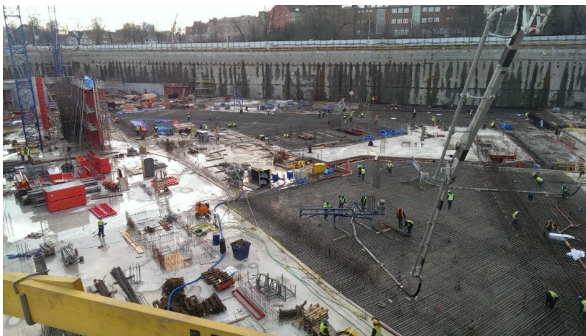
Rys. 6. Widok wykopu podczas prowadzonych prac po wypompowaniu z niego całej wody
