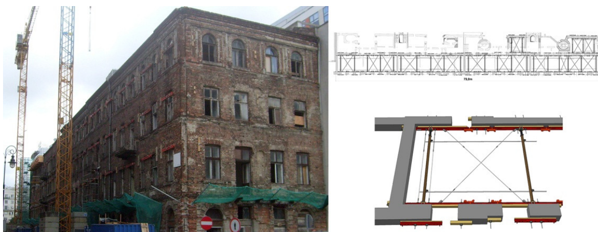
Rys. 9. Widok wzmocnienia od strony elewacji i schemat skratowań przeponowych
