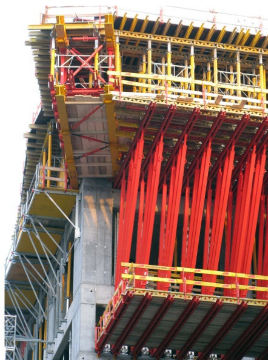
Rys. 6. Konstrukcja podtrzymująca 5 kondygnacji wsporników stropów, 30 m nad poziomem terenu
