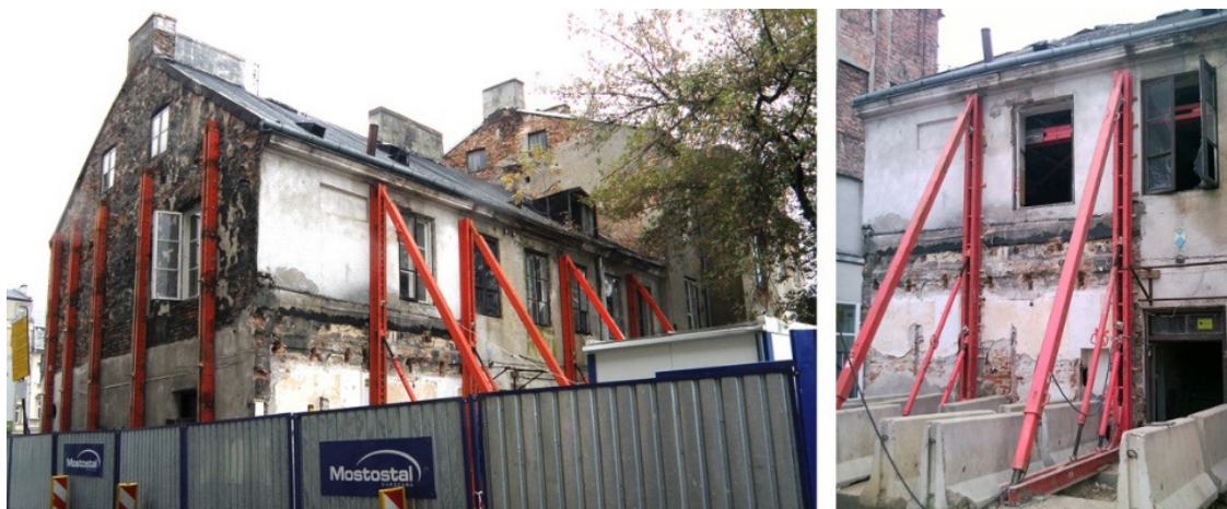
Rys. 11. Widok zewnętrznych fragmentów tymczasowej konstrukcji stężącej
