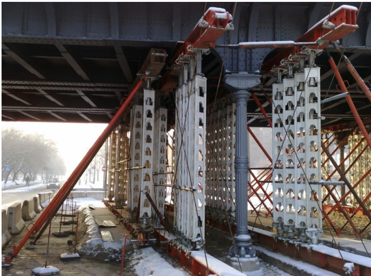
Rys. 14 Podparcie tymczasowe wiaduktu kolejowego z użyciem systemu HD 200
