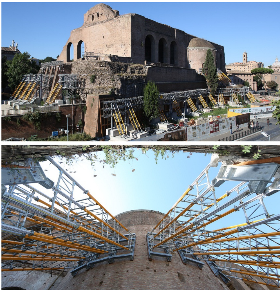
Rys. 7. Wyparcie zabezpieczające ścian Basilica Maxentius w Rzymie, wykonane z użyciem wież systemu PERI MULTIPROP
