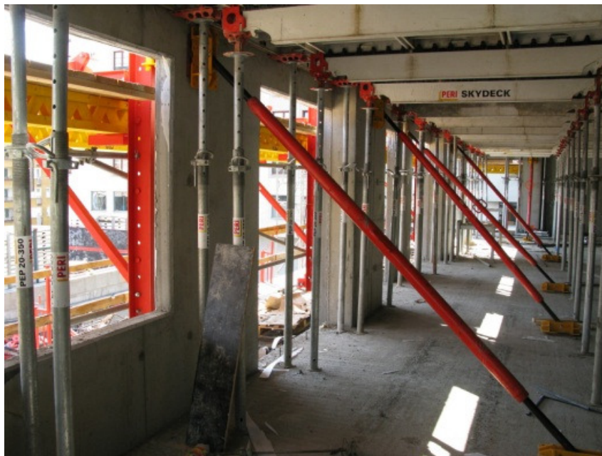
Rys. 5. Wypory wysokonośne SLS zabezpieczają wspornikowy fragment ściany zewnętrznej o grubości 15 cm. Na ścianach zawieszono pomosty robocze z deskowaniem, generujące siły poziome w zakotwieniach
