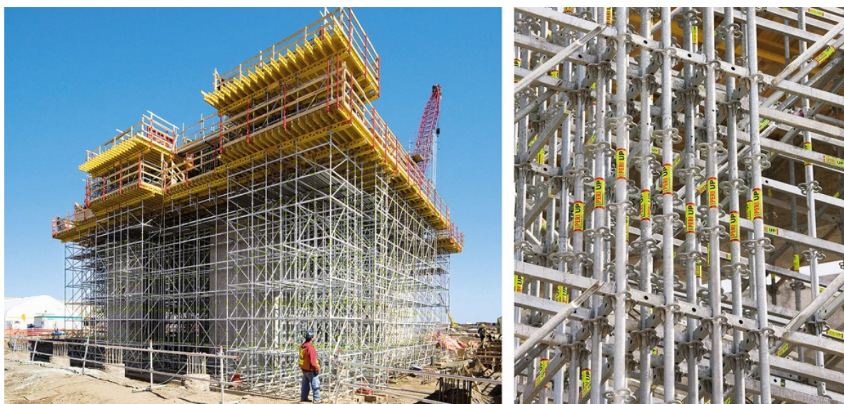
Rys. 4. Rusztowanie podporowe wykonane w systemie PERI UP Rosett Flex. Z prawej strony widoczne zagęszczenie słupków w rejonie koncentracji obciążeń
