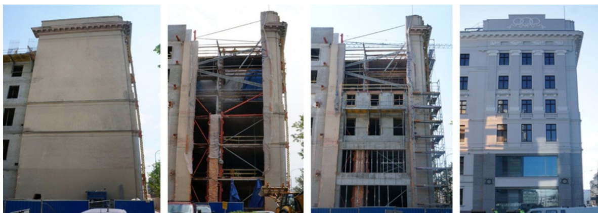
Rys. 8. Etapy zmiany ściany fasadowej kamienicy hr. E. Raczyńskiego w Warszawie
