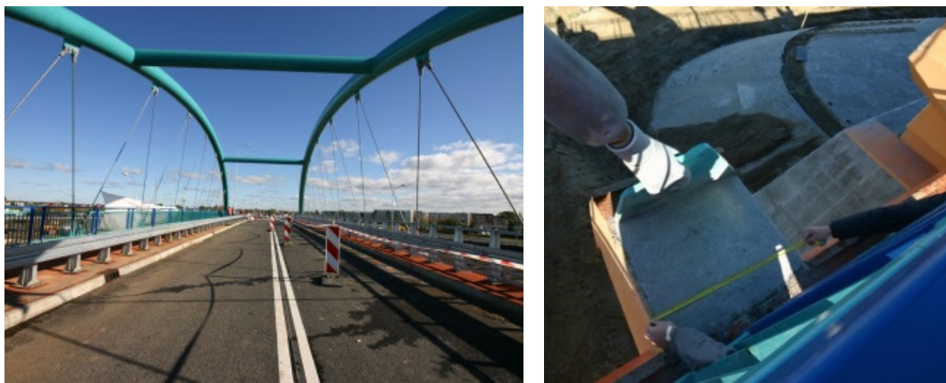
Rys. 4. Most w Nowym Dworze Gdańskim oraz badany wspornik poprzeczny
