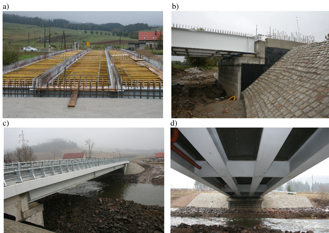
Rys. 6. Widok mostu w trakcie odbudowy i po jej zakończeniu
