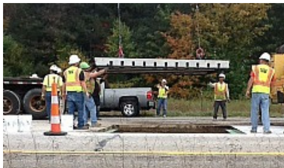
Rys. 4. Montaż płyty prefabrykowanej ( http://www.advanceconcreteproducts.com )
