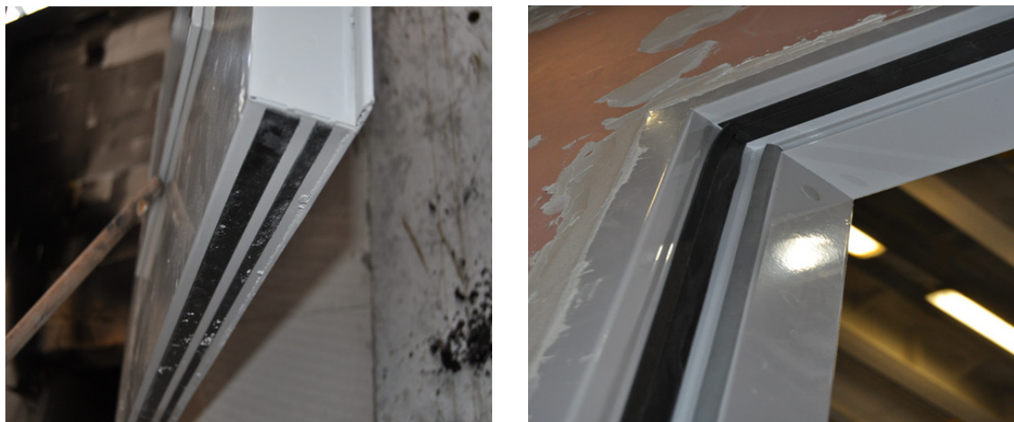
Rys. 1. Widok uszczelek pęczniejących w krawędzi skrzydła i krawędzi ościeżnicy
