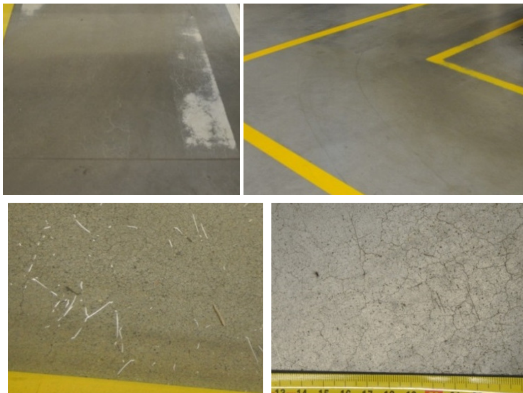
Rys. 4 Zużycie posadzki i pogorszenie estetyki posadzki w intensywnie użytkowanych alejach
