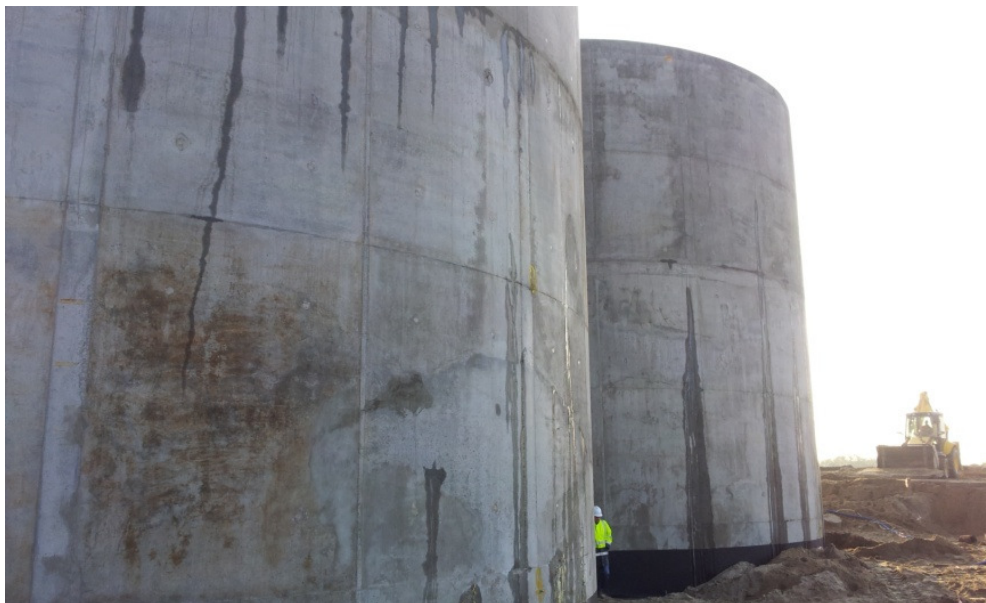
Rys. 2. Widoczny obraz zarysowań zbiorników od strony południowo-zachodniej (na pierwszym planie zbiornik nr 2)
