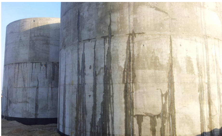
Rys. 1. Widoczny obraz zarysowań zbiorników od strony południowej (pierwszy plan – zbiornik nr 1)
