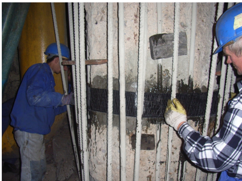
Rys. 7. Wzmacnianie jednego ze słupów
