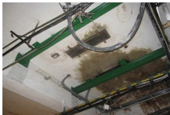
Rys. 10. Ruszt stalowy wykonany z dwuteowników hutniczych IPE 200
