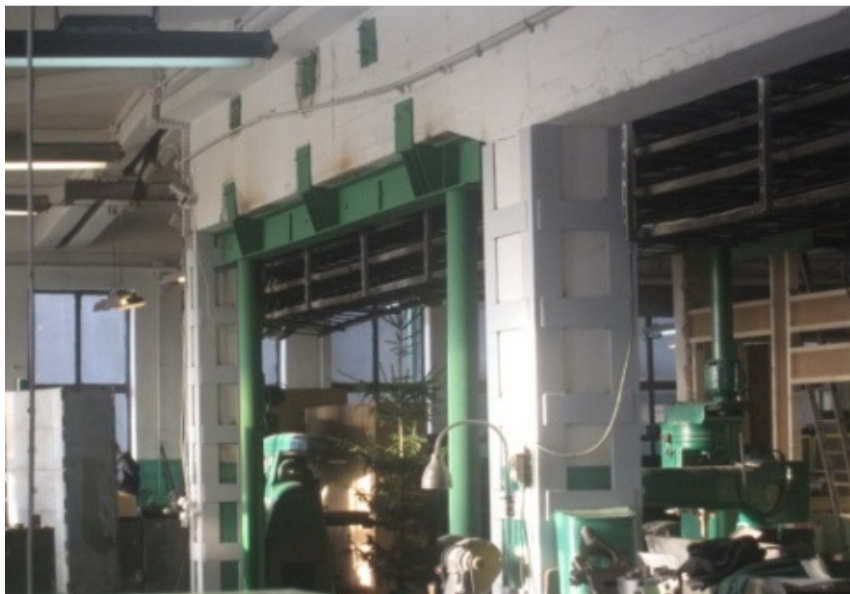
Rys. 11. Stalowa rama w osi głównej konstrukcji (podpierająca podciąg) z widocznymi wzmocnieniami słupów żelbetowych
