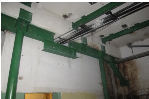
Rys. 9. Stalowa rama w osi głównej (podpierająca podciąg)
