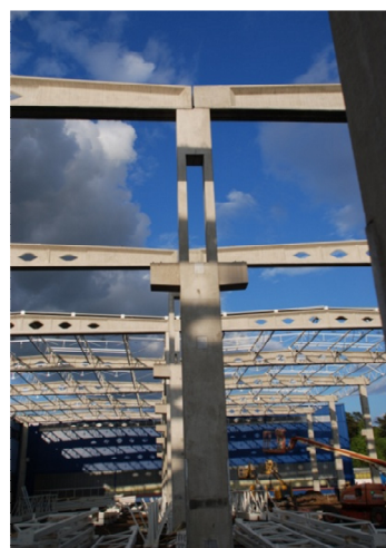
Rys. 3. Widok słupa w osi środkowej hali z otworem przełazowym dla chodnika obsługowego suwnicy
