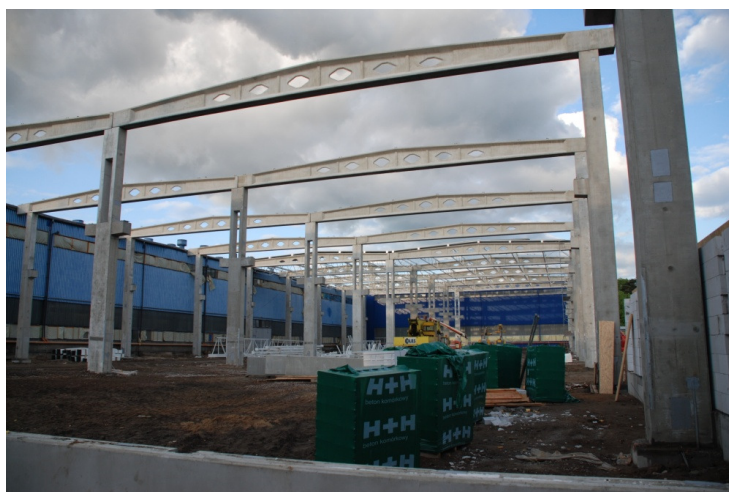
Rys. 2. Widok hali w trakcie montażu konstrukcji
