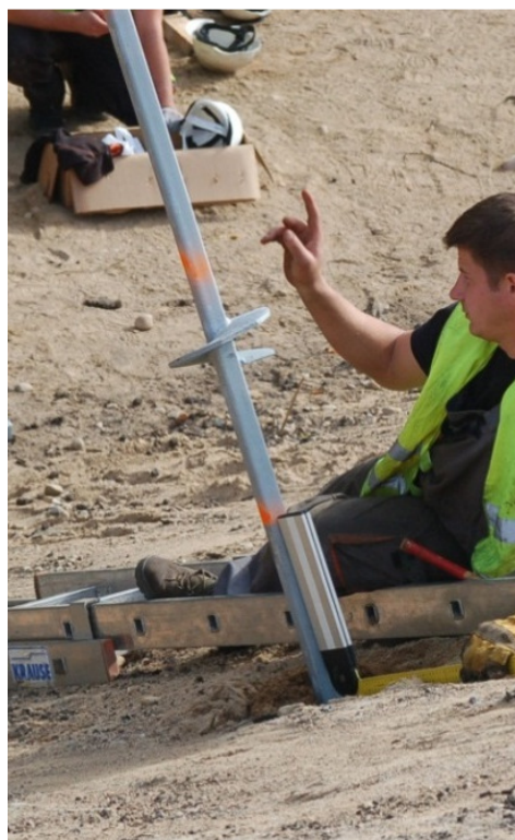
Rys. 8. Gwoździe wkręcane typu „Chance”
