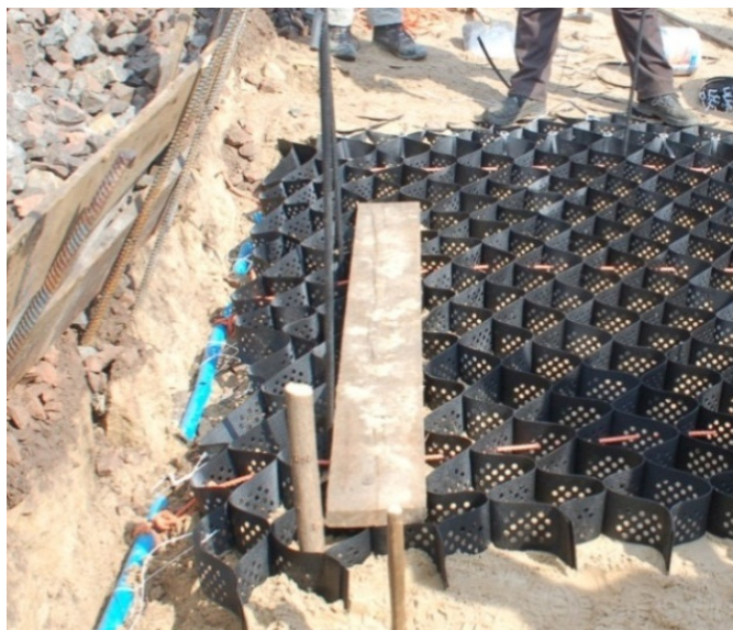
Rys. 7. Układanie geokraty przestrzennej
