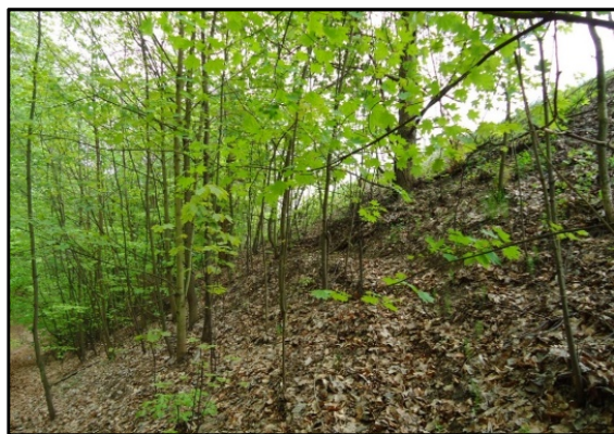
Rys. 9. Skarpa przed remontem
