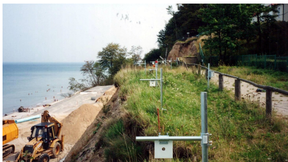
Rys. 15. Klif w rejonie „Bałtyku”. Prace zabezpieczające za pomocą gruntu zbrojonego (Fot. W. Subotowicz, 15.08.2000 r.)
