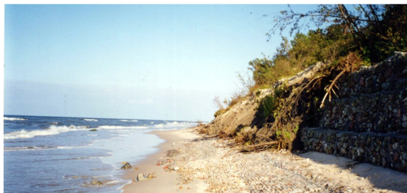
Rys. 12. Koluwium aktywnego klifu spełzło po gabionach do podnóża klifu (Fot. W. Subotowicz, 2.09.1998 r.)
