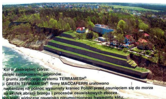
Rys. 17. Zabezpieczony klif w rejonie „Bałtyku”. Od strony wschodniej towarzyszy mu klif aktywny (Fot. Polibeton Warszawa)
