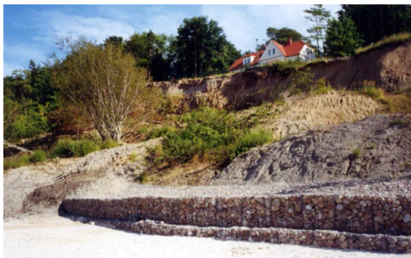
Rys. 5. Zagrożony „Bałtyk”. Wielkie osuwisko z koluwium spełzniętym na gabiony i plażę (Fot. W. Subotowicz, 30.06.1999 r.)
