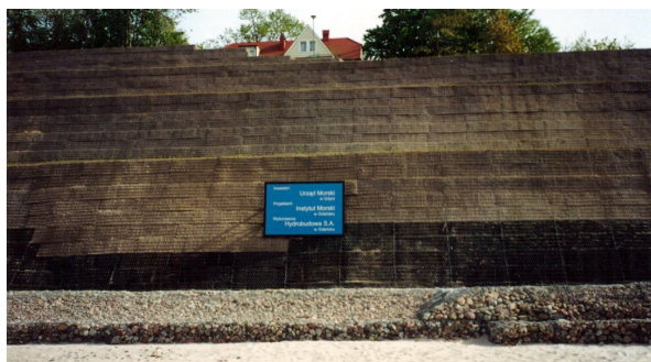
Rys. 16. Zabezpieczony klif w rejonie „Bałtyku” za pomocą gruntu zbrojonego. U podnóża opaska brzegowa z gabionów (Fot. W. Subotowicz, 26.05.2001 r.)
