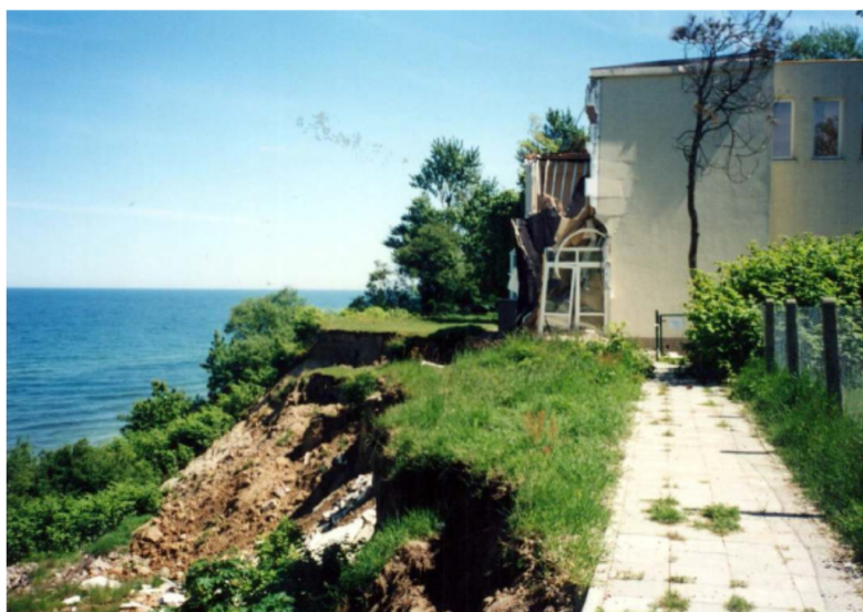
Rys. 3. Częściowo zniszczony ośrodek wypoczynkowy „Horyzont” na bezpośrednim zapleczu aktywnego klifu (Fot. W. Subotowicz. 3.06.2002)
