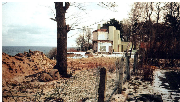
Rys. 11. Prace zabezpieczające klif za pomocą gruntu zbrojonego w rejonie ośrodka wypoczynkowego „Horyzont” (Fot. W. Subotowicz, 13.02.2009 r.)
