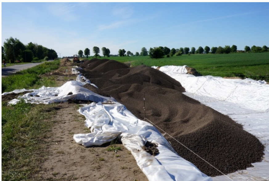
Rys. 8. Wykonywanie materaca z keramzytu [zdjęcie ZZDW Koszalin]
