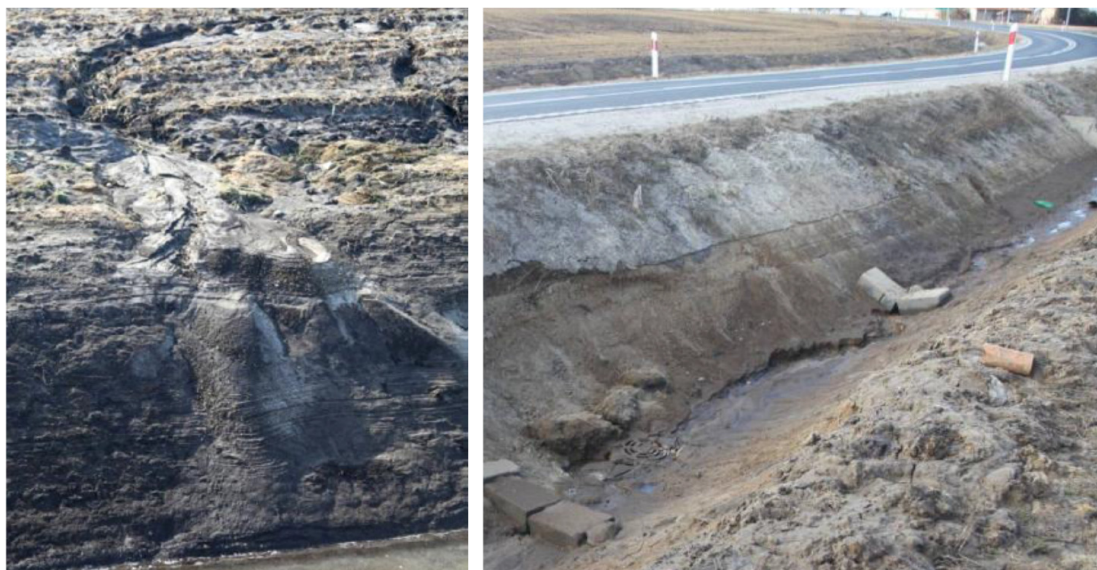
Rys. 4. Przykłady abrazji, powstania stożka napływowego i uszkodzenia drenażu rolniczego w wyniku wykorzystania go w systemie odwodnienia przy średnim spływie wody do rowu przydrożnego
