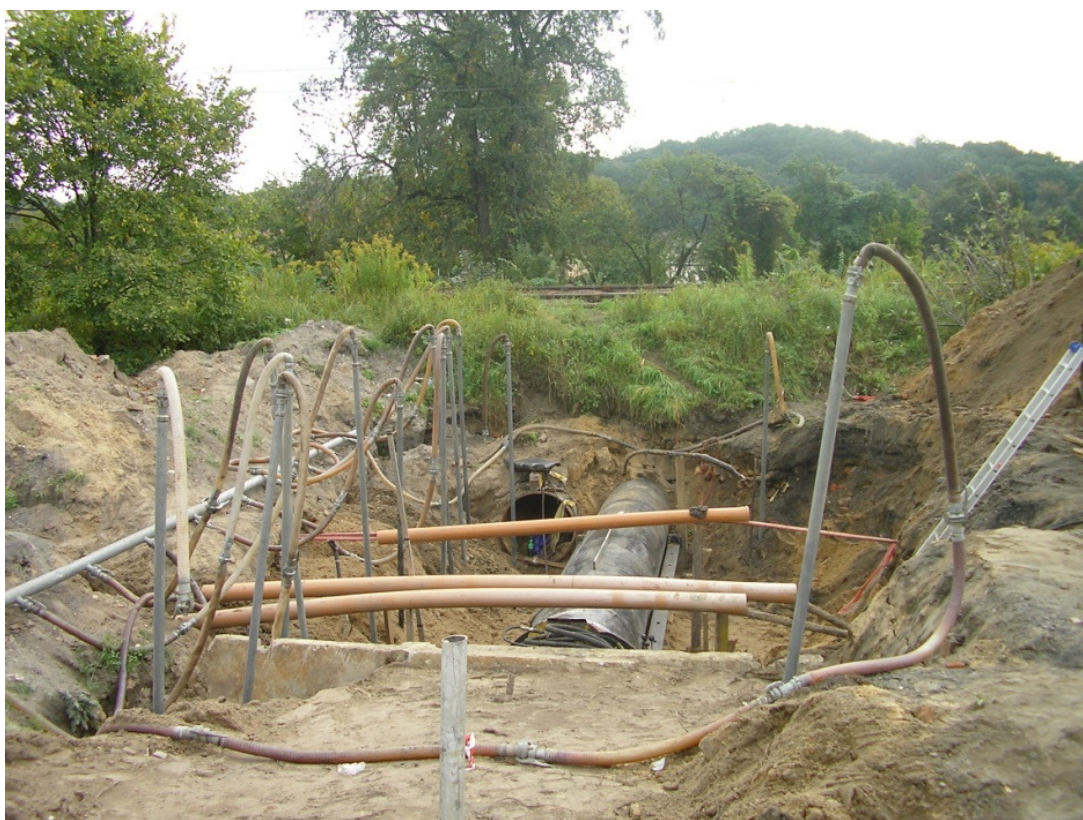
Rys. 2. Instalacja rury osłonowej o średnicy 1000 mm pod nasypem kolejowym na trasie Szczecin-Kostrzyn w Szczecinie, za pomocą przecisku niesterowanego transportem urobku przenośnikiem ślimakowym
