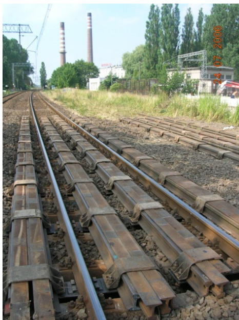
Rys. 3. Zabezpieczenie, za pomocą konstrukcji odciążającej, torów kolejowych na trasie Szczecin-Kostrzyn w Szczecinie, w czasie realizacji przecisku pod nasypem kanalizacji deszczowej
