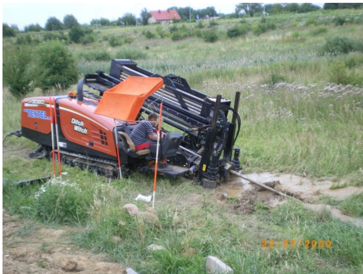
Rys. 1. Przewiert sterowany – wciąganie rury DN 400 za pomocą wiertnicy JT 3020 Ditch Witch przy ul. Wkrzańskiej [zdj. Włodzimierz Leppert]
