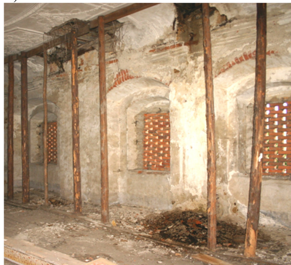
Rys. 4. Uszkodzenia stropów kolejnych kondygnacji wywołane lokalnym oddziaływaniem wody: a) uszkodzenia stropu kondygnacji III, b) uszkodzenia stropu kondygnacji II
