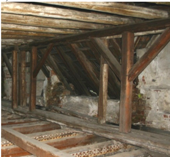
Rys. 4. Uszkodzenia stropów kolejnych kondygnacji wywołane lokalnym oddziaływaniem wody: a) uszkodzenia stropu kondygnacji III, b) uszkodzenia stropu kondygnacji II
