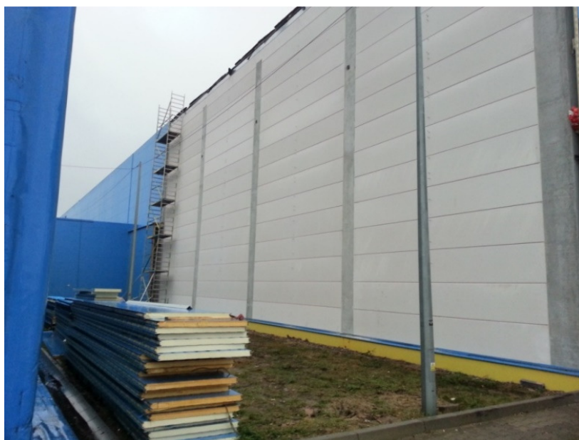
Rys. 7. Widok elewacji w osi 21 w trakcie prowadzenia prac naprawczych
