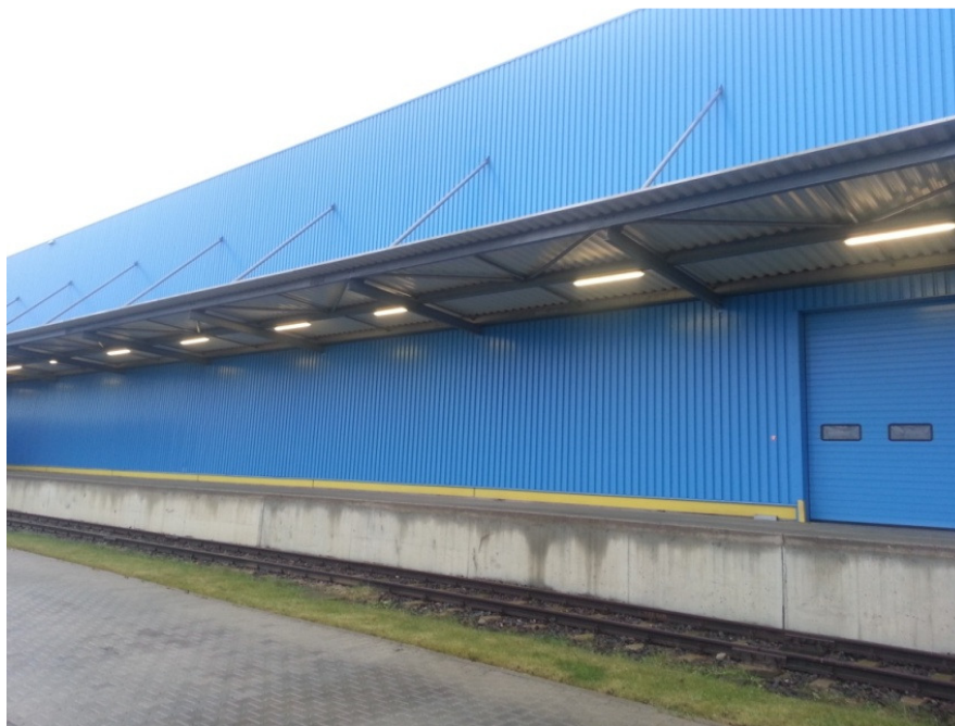
Rys. 9. Widok elewacji w osi J po wykonaniu naprawy
