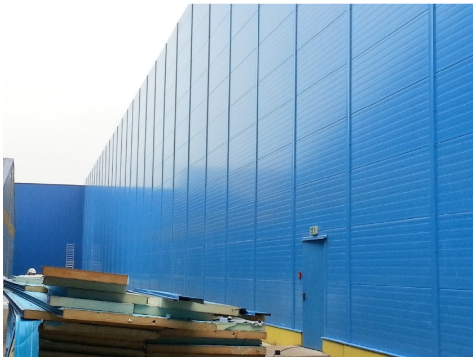
Rys. 8. Widok elewacji w osi 21 po przeprowadzonej naprawie
