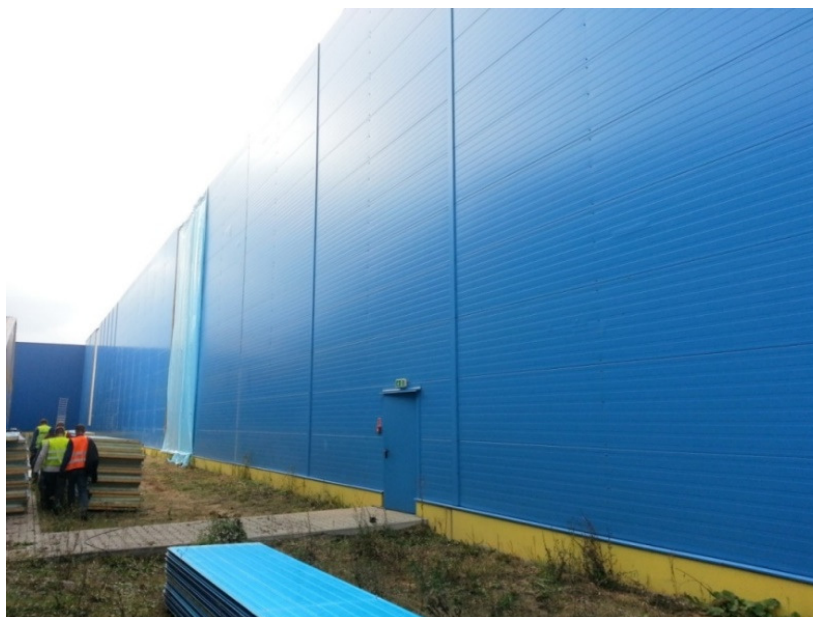
Rys. 6. Widok elewacji w osi 21 przed wymianą płyt z uszkodzeniami
