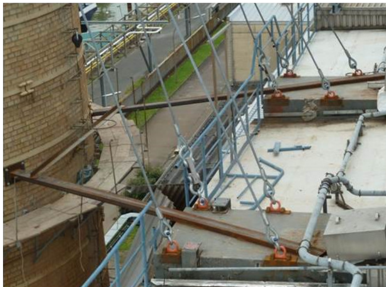
Rys. 4.3. Dolna część konstrukcji podwieszenia na elektrofiltrze
