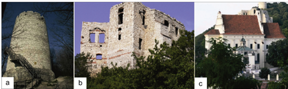
Rys. 1. Obiekty „białej” murowanej architektury Kazimierza Dolnego wykonane z lokalnego surowca – opoki: a) baszta, b) zamek, c) kościół Farny (fot. M. Kurowska)
