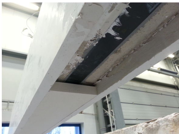
Rys. 4. Montaż izolacji ogniochronnej
