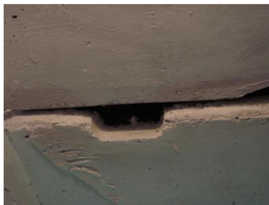
Rys. 7. Niedbale wykonane połączenia między prefabrykatami w piwnicach
