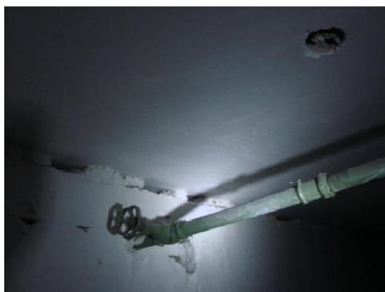
Rys. 7. Niedbale wykonane połączenia między prefabrykatami w piwnicach
