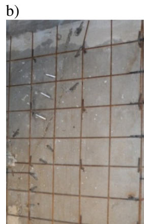
Rys. 14. Wzmocnienie konstrukcji szybu windowego – jednego segmentu na III piętrze
