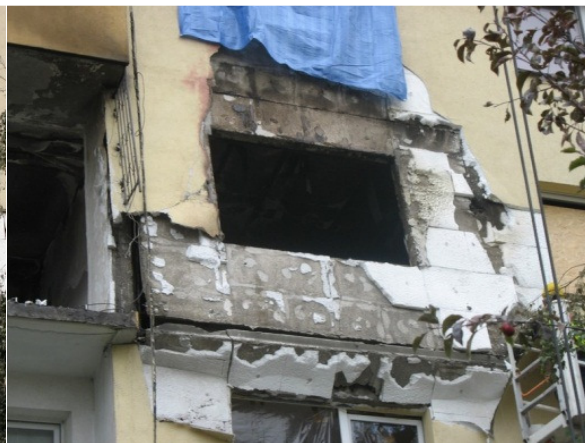
Rys. 6. Zniszczona ściana osłonowa w kuchni mieszkania M2 w trakcie demontażu
