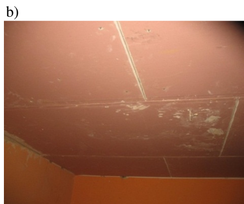
Rys. 13. Wzmocnienie zarysowanych płyt stropowych: a) wzmocnienie stropu, b) zabezpieczenie wzmocnienia płytami gipsowo-kartonowymi
