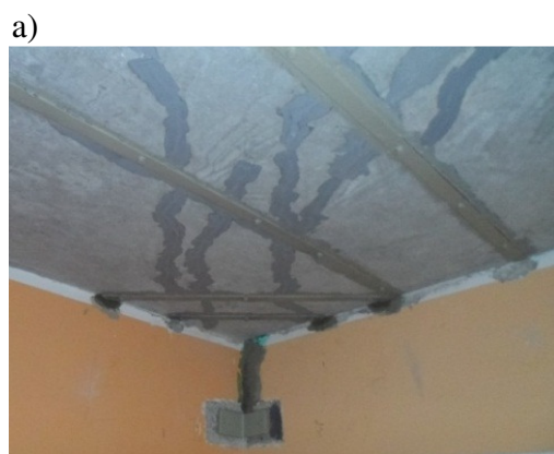
Rys. 13. Wzmocnienie zarysowanych płyt stropowych: a) wzmocnienie stropu, b) zabezpieczenie wzmocnienia płytami gipsowo-kartonowymi
