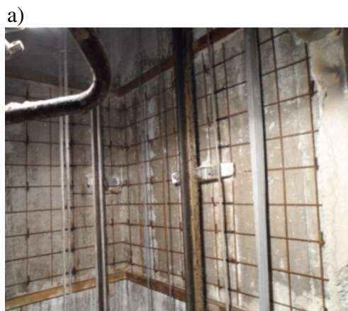
Rys. 14. Wzmocnienie konstrukcji szybu windowego – jednego segmentu na III piętrze
