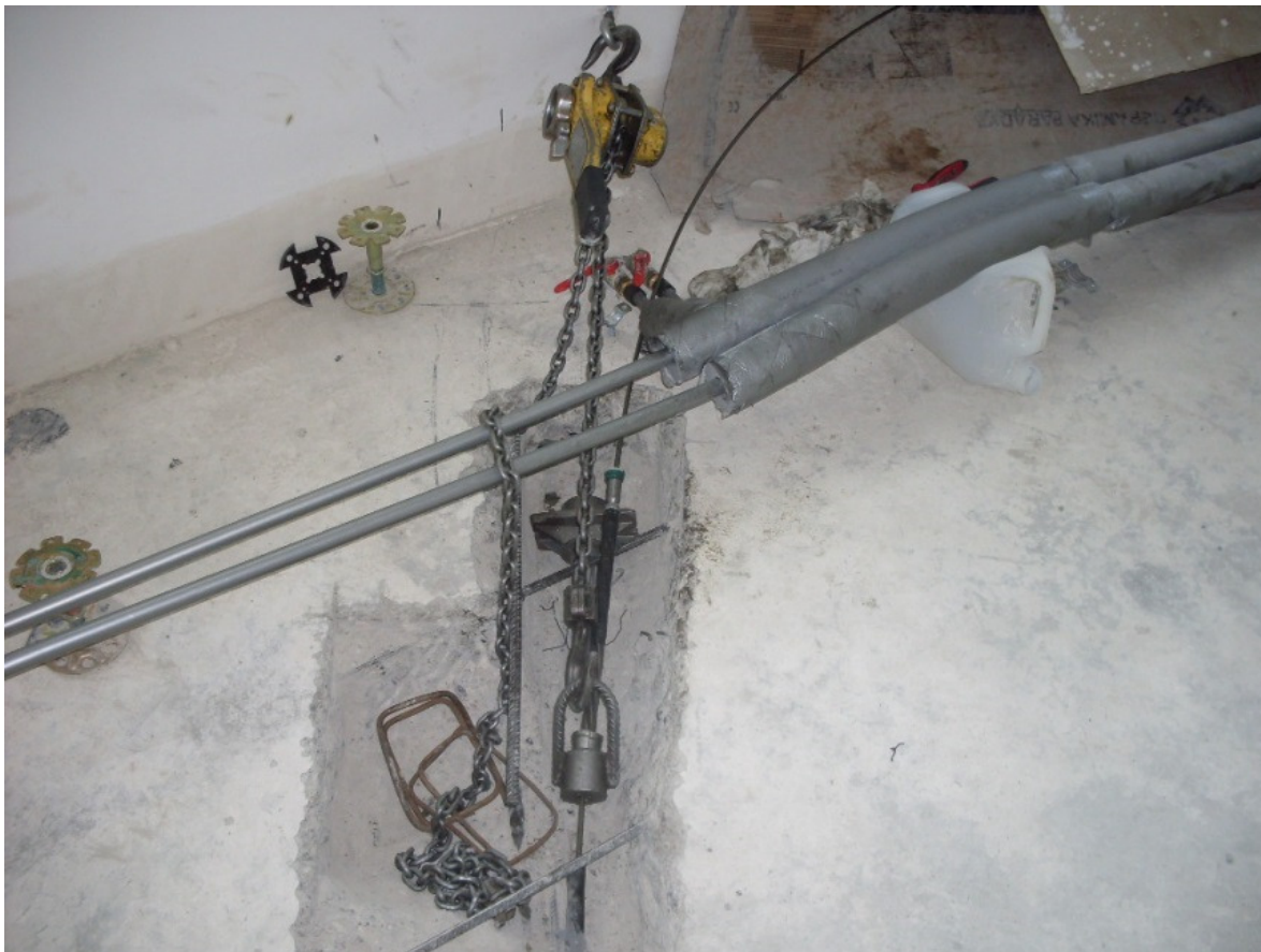
Rys. 7. Wciąganie nowego splotu w miejsce starego.
