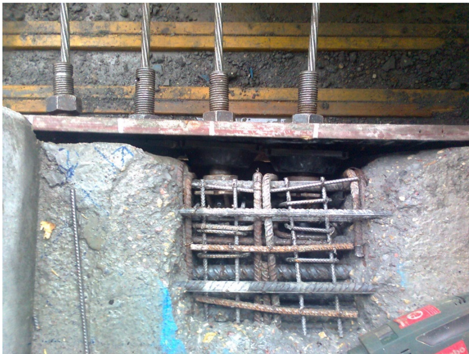
Rys. 3. Strefa zakotwienia przygotowana do ponownego wypełniania: sploty wymienione, dozbrojenia zamontowane, powierzchnie betonu zagruntowane
