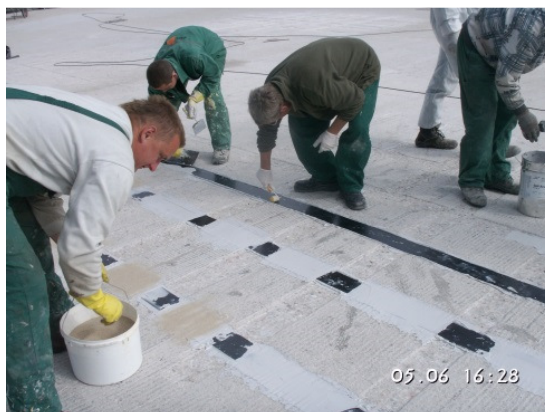
Rys. 5. Naklejanie taśm CFRP na górną powierzchnię płyty
