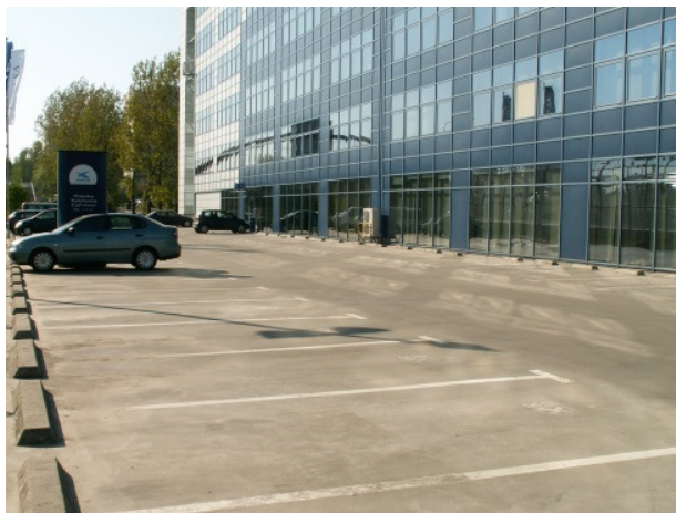
Rys. 1. Widok płyty parkingu naziemnego wraz z przyległym budynkiem biurowo-usługowym
