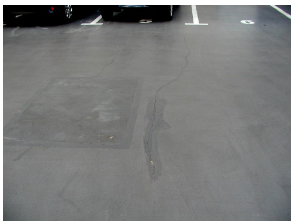
Rys. 6. Rysy na górnej powierzchni płyty (w tym na wcześniej wykonanych naprawach)
