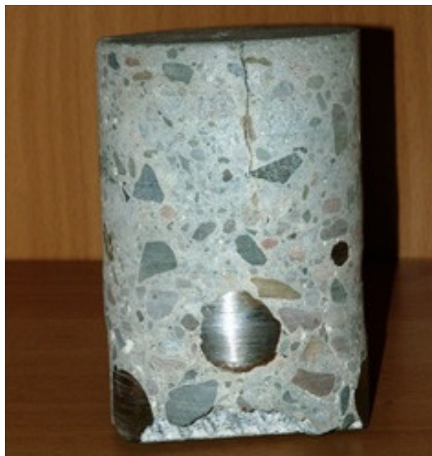
Rys. 3. Widok próbki walcowej z górnej części płyty; widoczne zbrojenie podporowe
