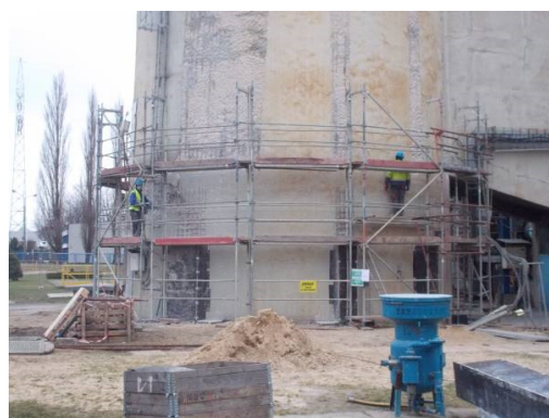
Rys. 4. Montaż rusztowań do budowy rusztu
