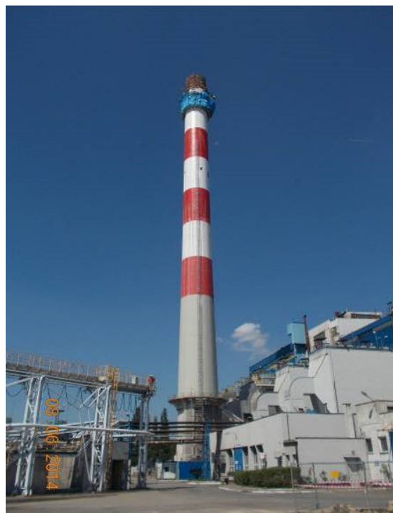
Rys. 10. Kolejne etapy betonowania nowego trzonu w ślizgu
