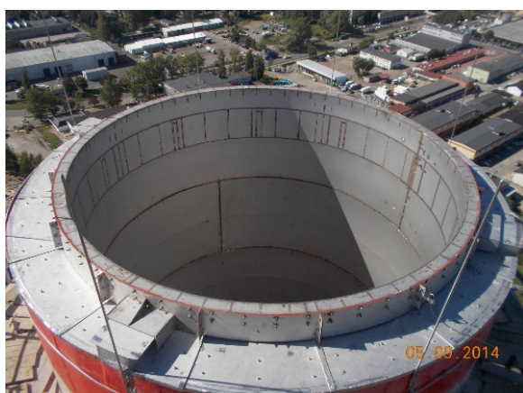
Rys. 16. Głowica komina po zamontowaniu
