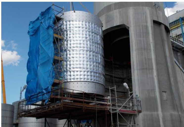
Rys. 14. Wsuwanie do wnętrza komina segmentu przed jego powiększeniem przewodu stalowego
