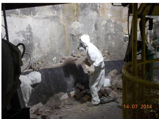
Rys. 11. Rozbiórka wymurówki
