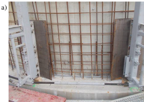
Rys. 9. Szalunki do betonowania trzonu w ślizgu
