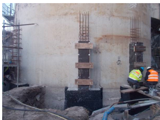
Rys. 3. Zbrojenie i szalowanie pilastrów
