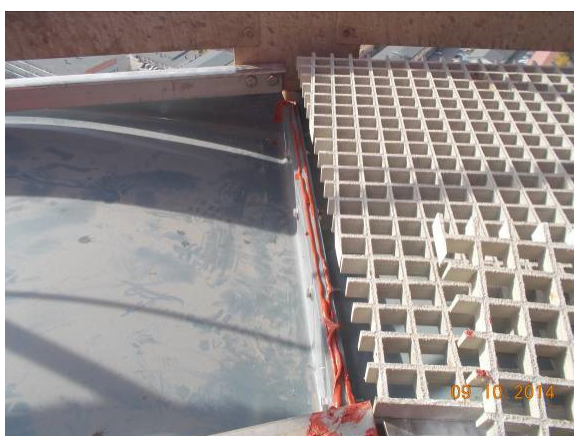
Rys. 17. Wyłapywacz skroplin
