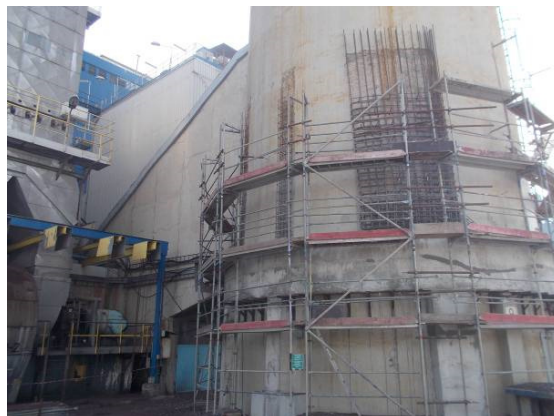
Rys. 6. Zbrojenie otworu montażowego
