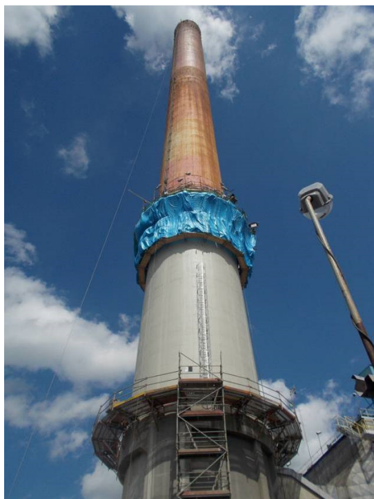
Rys. 10. Kolejne etapy betonowania nowego trzonu w ślizgu
