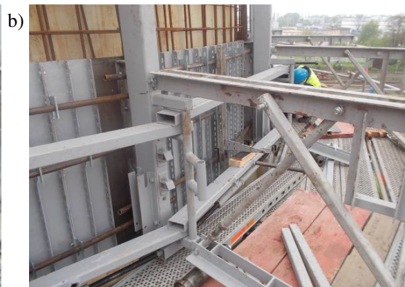
Rys. 9. Szalunki do betonowania trzonu w ślizgu
