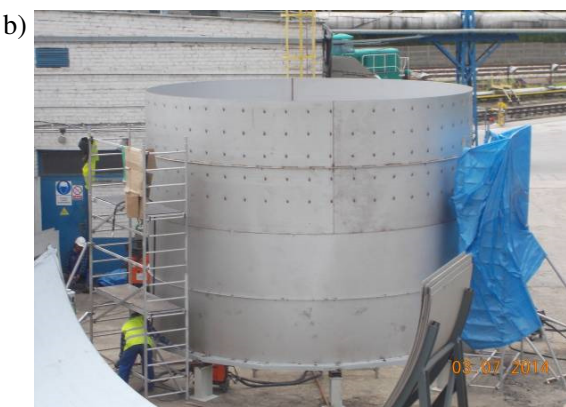
Rys. 15. Montaż segmentów stalowego przewodu komina
