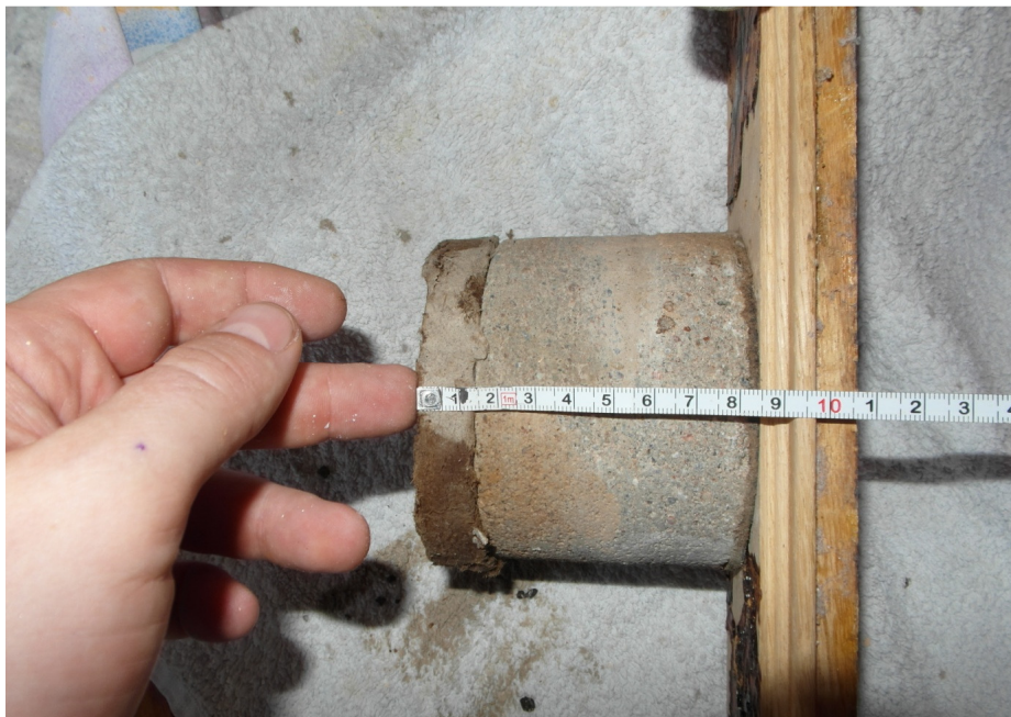
Rys. 4. Odwiert w warstwach wykończeniowych ułożonych na analizowanym stropie
