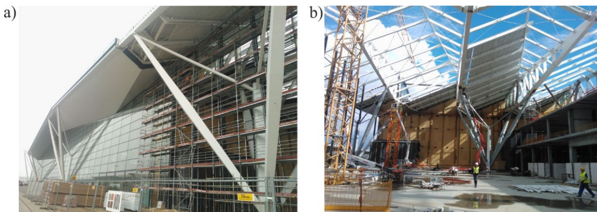
Rys. 3. Rozbudowa terminala: a) połączenie części istniejącej z częścią dobudowywaną (fasada północna), b) konstrukcja dachu
