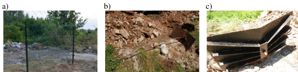
Rys. 2. „Zakotwienie” odciągów (opis w tekście): a) przykładowy widok przed katastrofą; b), c) odkrywka kotwy po katastrofie
