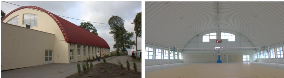
Rys. 2. Hala sportowa z przykryciem w technologii ABM: a) widok z zewnątrz b) widok wnętrza hali
