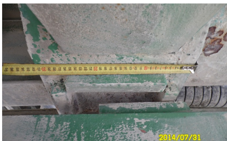
Rys. 7. Przesunięcie poprzeczne belki w stosunku do podstawy łożyska przesuwnej
