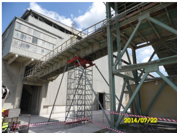
Rys. 1. Widok konstrukcji (z tymczasową podporą) od strony zachodniej
