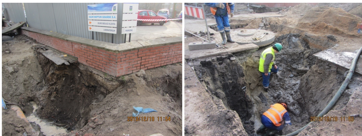
Rys. 5. (a) Wykop przy murku obok parkingu, (b) Wykop przy studni R6 wykonany w celu usunięcia awarii wodociągu [5]
