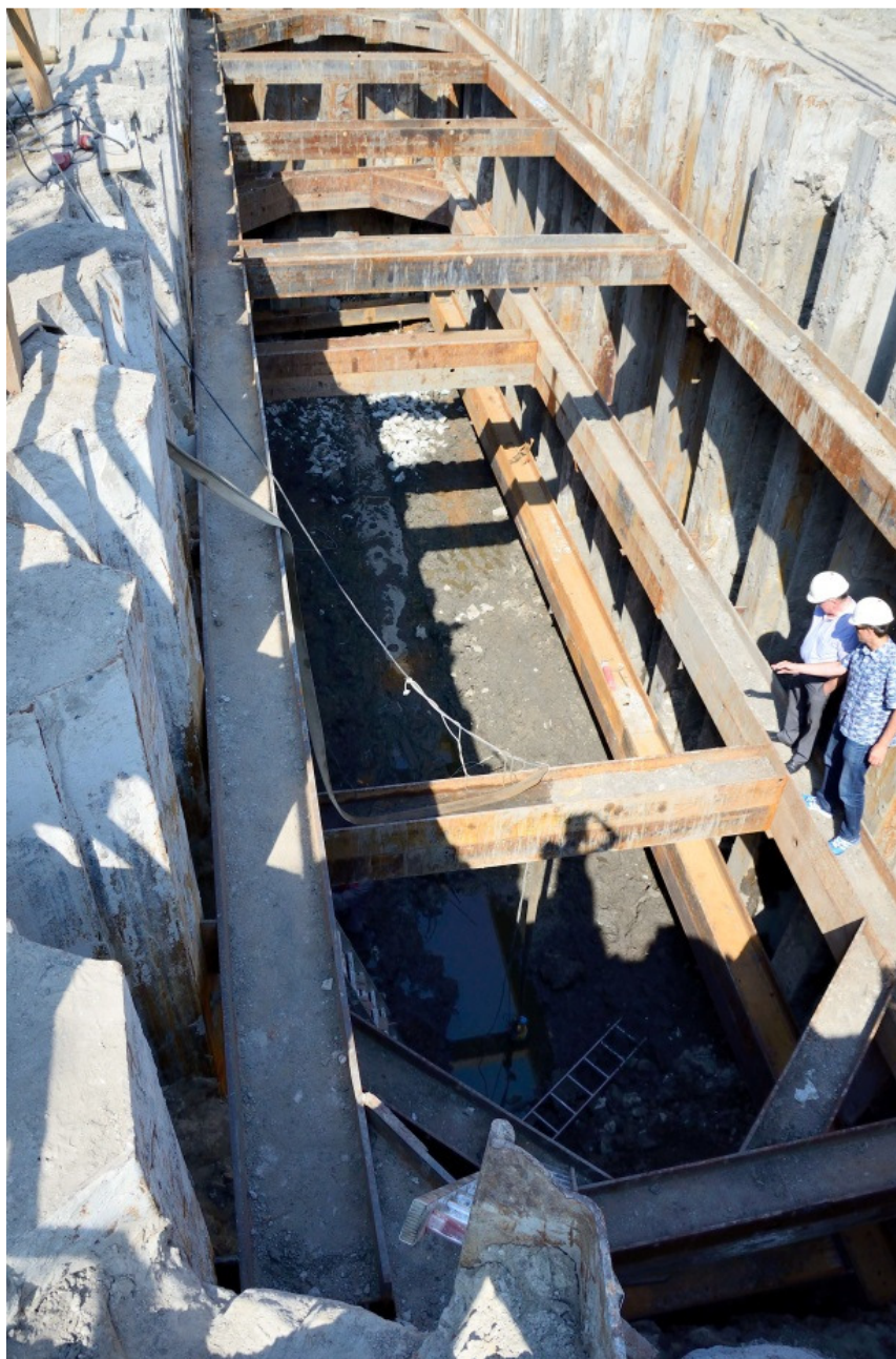
Rys. 7. Głęboki wykop w miejscu awarii. Fot. własna
