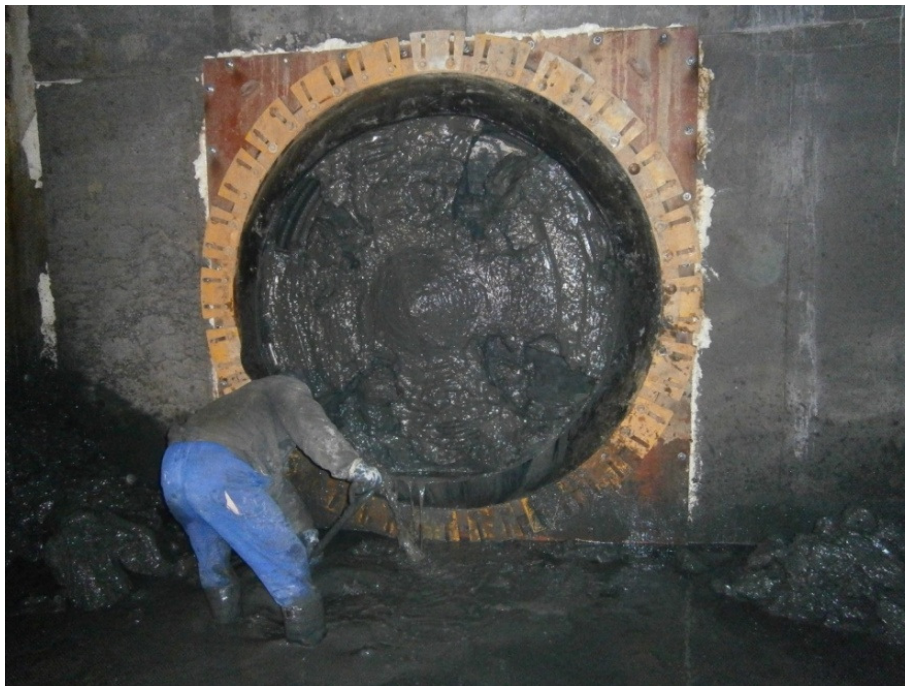
Rys. 4. Wejście głowicy do komory K5 [5]
