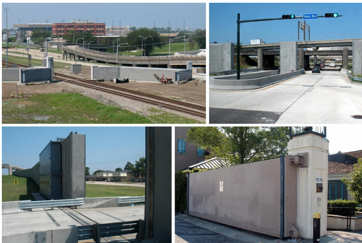
Rys. 4. Przejścia dróg komunikacyjnych przez groble przeciwpowodziowe (zdjęcia autora)
