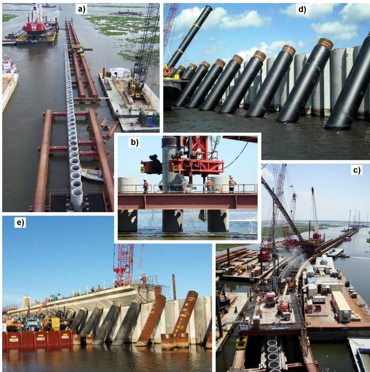
Rys. 6. Zdjęcia z budowy bariery wzdłuż kanału IHNC (z uprzejmości USACE): a) montaż pomostu i transport pali ściany piętrzącej, b) wbijanie betonowych pali rurowych ściany piętrzącej, c) wypełnianie pali ściany i wbijanie ukośnych zastrzałów stalowych, d) nakładanie polietylenowych „rękawów” na stalowe zastrzały, e) montaż prefabrykatów oczepu bariery z jezdnią
