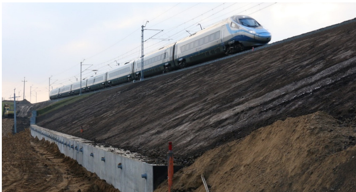
Rys. 14. Odbudowany nasyp od strony osuwiska
