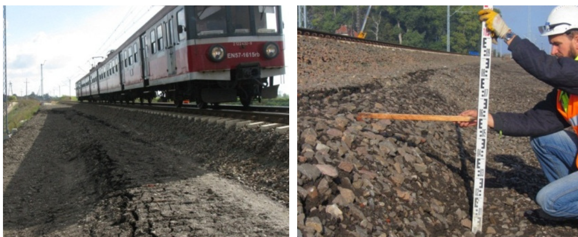
Rys. 9. Korona nasypu w dniu 26.09.2014 r. (przemieszczenie około 60 cm)
