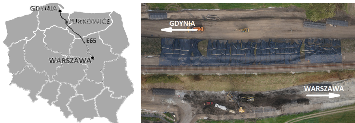
Rys. 1. Linia E65 na odcinku Warszawa – Gdynia z zaznaczeniem miejscowości Jurkowiec (koło Malborka). Zdjęcie fotogrametryczne analizowanego nasypu (autorstwa Geopartner Sp. z o.o.)
