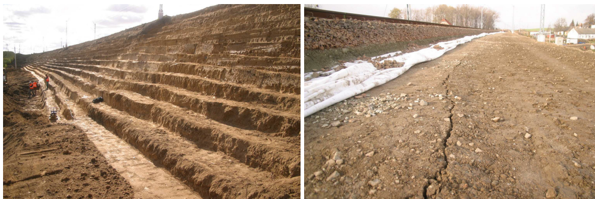
Rys. 5. a) Wykonanie schodkowego skarpowania w celu poszerzenia nasypu o około 1 m od strony prawej nasypu, b) Pęknięcie korony nasypu pod torem nr 1
