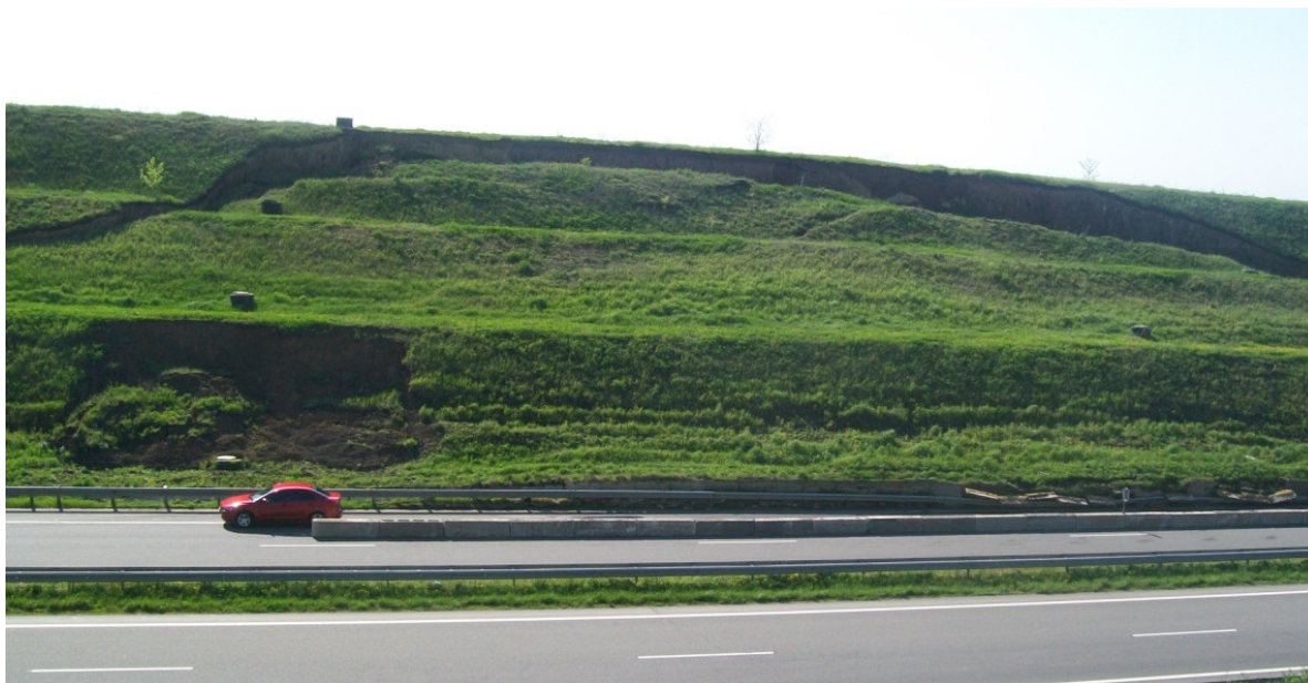
Rys. 4. Ogólny widok osuwiska na km 311 drogi „Kijów – Odessa”
