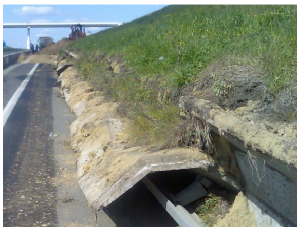
Rys. 5 Przesunięcie mas gruntowych osuwiska. Rys. 6 Zniszczenie powierzchniowego systemu odprowadzenia wód
