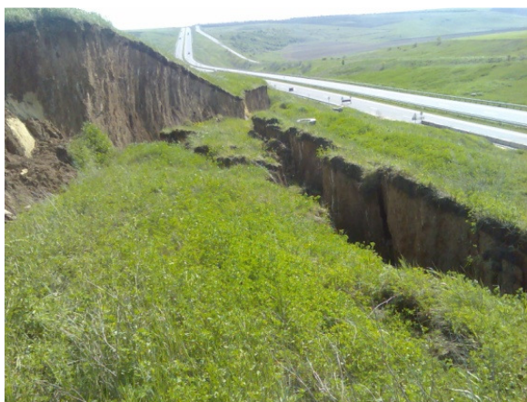
Rys. 5 Przesunięcie mas gruntowych osuwiska. Rys. 6 Zniszczenie powierzchniowego systemu odprowadzenia wód
