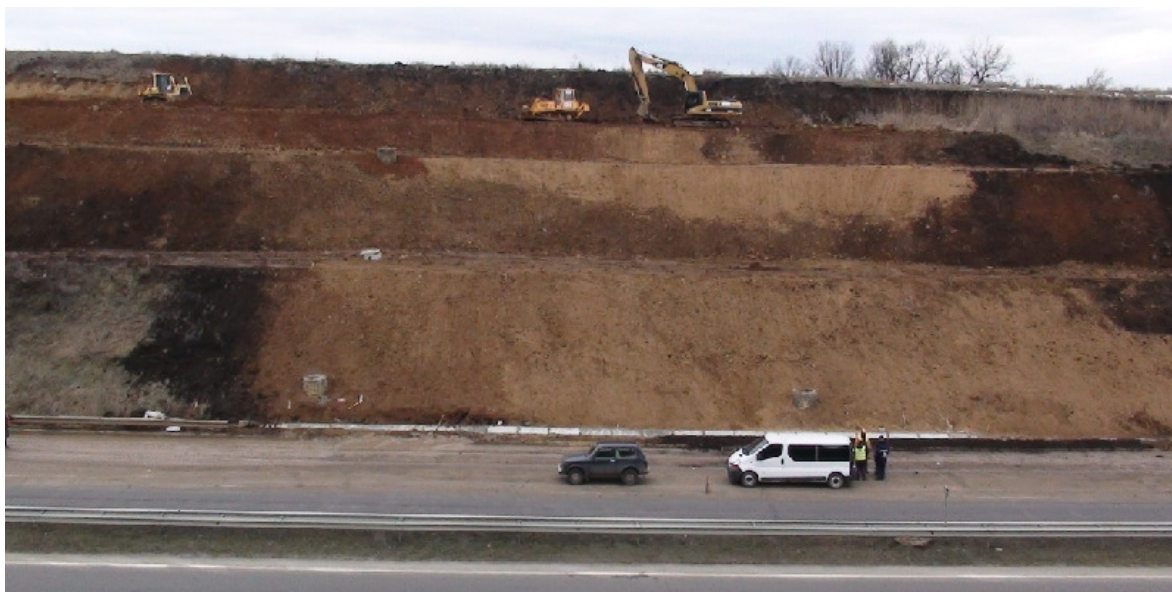
Rys. 9. Odbudowana skarpa wykopu przed powtórным zniszczeniem (luty 2015 r.)
