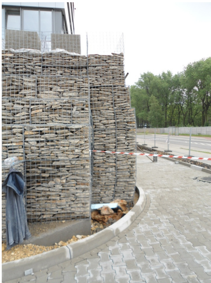
Rys. 1. Widok konstrukcji gabionowej w trakcie realizacji
