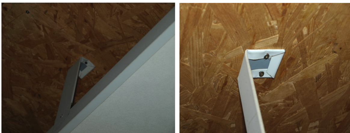
Rys. 6. Mocowanie płyt sufitu podwieszonego do płyt OSB-4
