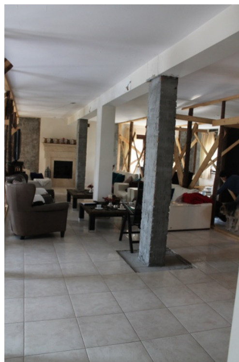
Rys. 5. Dodatkowe podparcie podciągu i podstemplowanie stropu parteru
