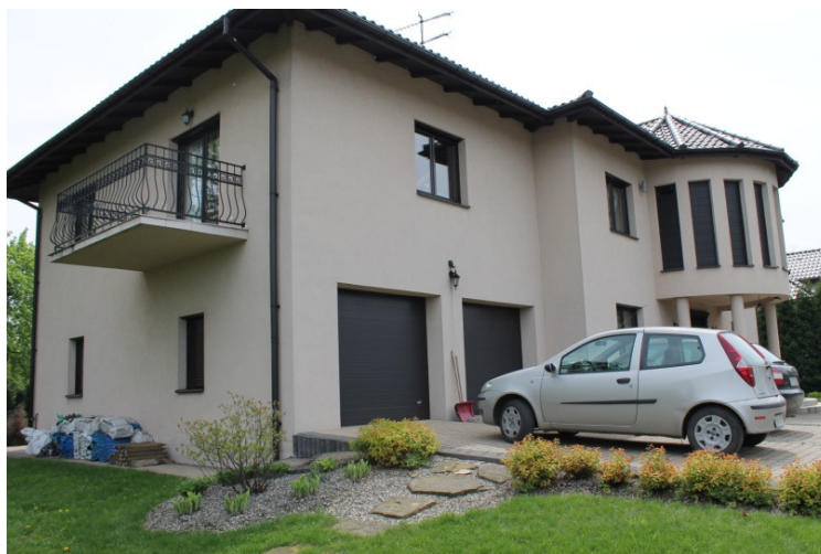
Rys. 1. Widok ogólny bryły budynku
