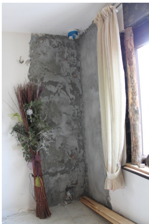
Rys. 4. Przemurowane naroże ścian parteru
