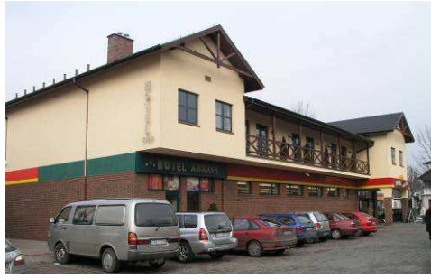
Rys. 1. Widok budynku od strony frontowej (północno-wschodniej)
