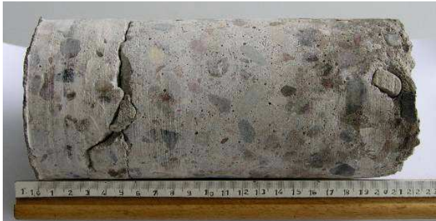
Rys. 5. Odwiert próbki betonu
