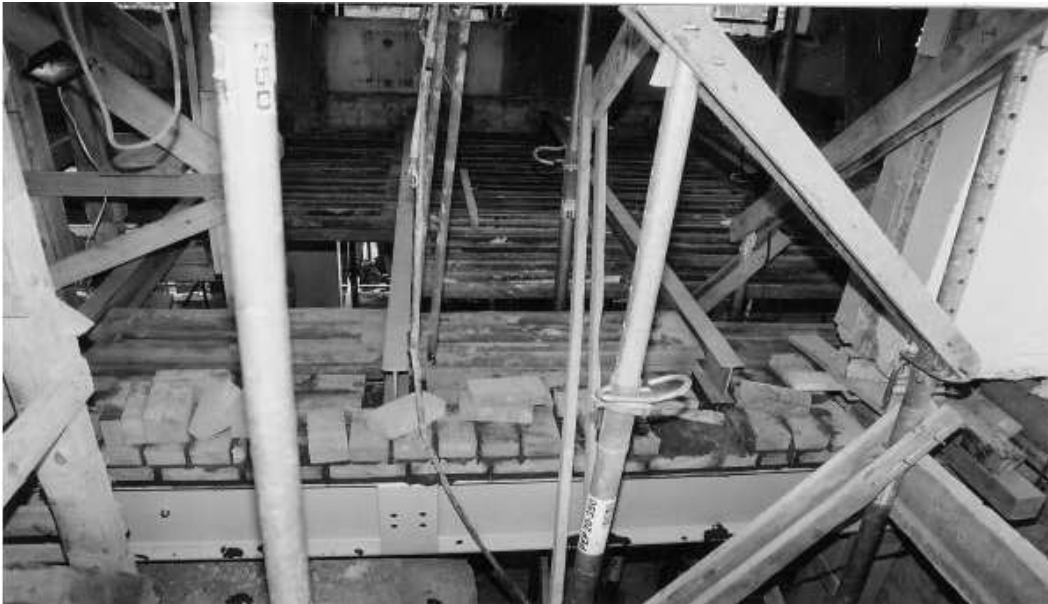
Rys. 8. Fragment nadproża stalowego nad parterem (w miejscu w którym rozpoczęła się katastrofa budowlana) z odbudowywaną ścianą konstrukcyjną oraz fragmentem stropu z belek dwuteowych z płytami WPS. Widok z góry na strop nad parterem
