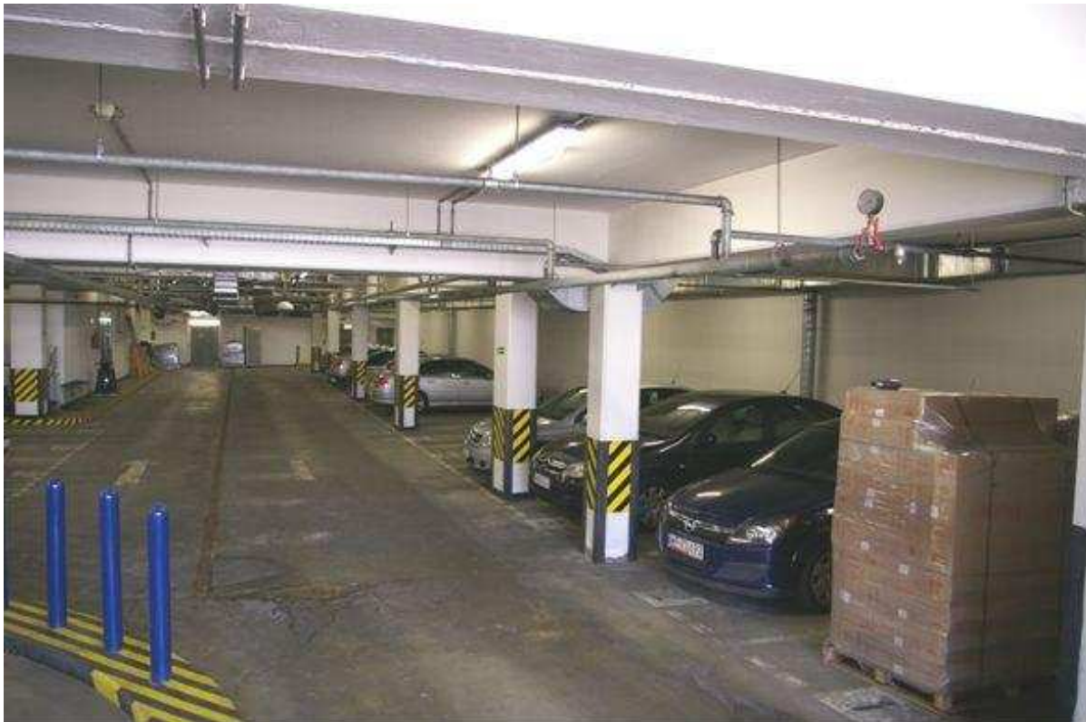
Rys. 1. Widok północnej części garażu
