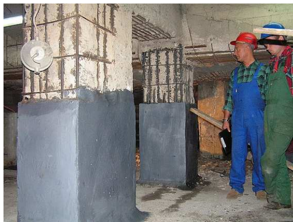
Rys. 9. Dolne odcinki słupów po oczyszczeniu i uzupełnieniu kompozycjami żywicznymi
