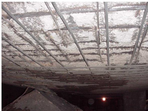
Rys. 8. Uzupełnianie dolnego zbrojenia płyty przy lejach do odprowadzania popiołu
