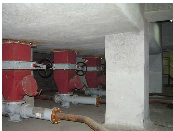
Rys. 10. Ramowa konstrukcja wsporcza pod kotły po przeprowadzonej naprawie oraz nowa instalacja technologiczna do odprowadzania popiołu
