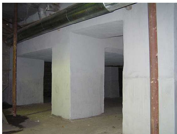
Rys. 11. Słupy i rygle żelbetowej konstrukcji ramowej po kompleksowym wykonaniu prac naprawczych
