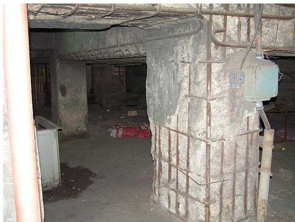
Rys. 4. Przerwane strzemiona w słupie, dolne pręty rygli zakotwione nieprawidłowo w otulinie słupa
